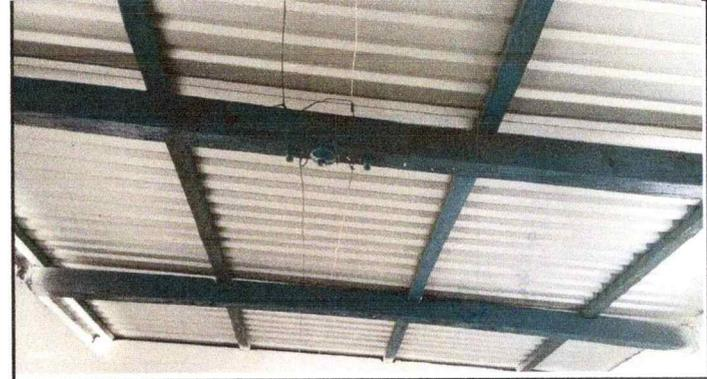
Foto 4. Se observa las costanera de madera y lámina con gotera del módulo 1
