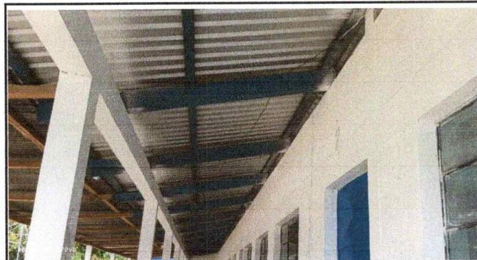
Foto 3. Se observa las costaneras, cargaláminas de madera en ma estado
