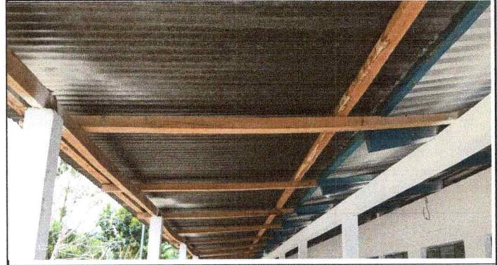
Foto 2. Se observa el deterioro de las laminas del módulo 1
